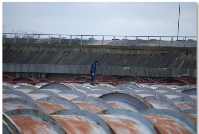
Рис. 1/5 Комплексы расходомерные ИРКА установленные на Главной насосной станции подачи воды в магистральный канал. Диаметр труб 3600 мм
