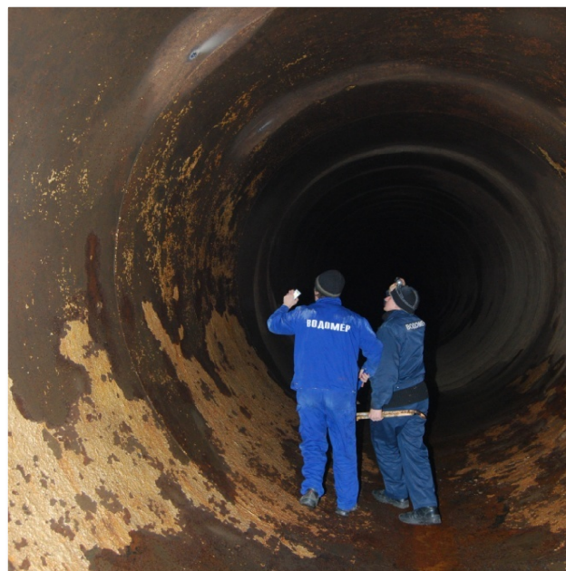
Рис. 1/6 Процесс монтажа комплексов расходомерных ИРКА на трубах Ду3600 «Главной насосной станции подачи воды в магистральный канал»
