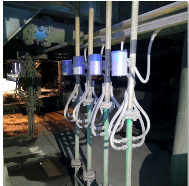
Рис. 1/3 Комплексы расходомерные ИРКА установленные в системе охлаждения Доменной печи №4 на трубах Ду32 ПАО «Запорожсталь»
