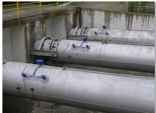
Рис. 1/4 Комплексы расходомерные ИРКА установленные на «Малых насосных станциях орошения УГКМК». Диаметры труб от 200 до 800 мм
