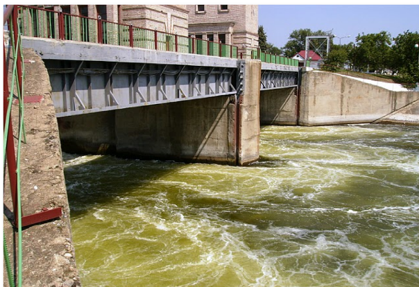
Рис. 9/2 Гидросооружение магистрального канала подачи воды на орошение
