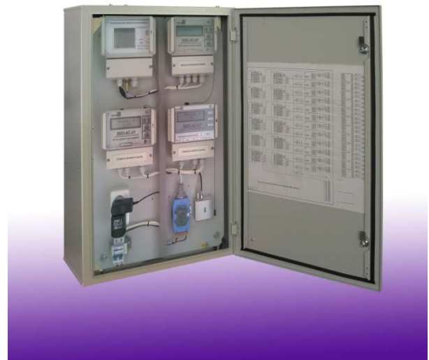
Рис. 9/1 Вычислительно-измерительный комплекс ВИК-ЭХО:З-ППК-ГС, установленный на гидросооружении Явкинського магистрального канала
