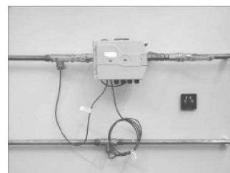
Рис. 3 Пример установки счетчика тепла
