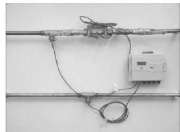
4.7.1 Тепловычислитель поставляется установленным на гидравлической части счетчика тепла. В зависимости от положения установки гидравлической части (горизонтальное или вертикальное) можно тепловычислитель поворачивать в шагах на 90°.
