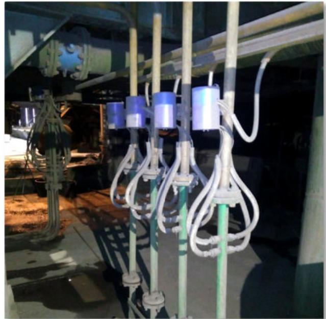
Рис. 1/3 Расходомеры-счетчики IPKA, установленные в системе охлаждения Доменной печи №4 на трубах Ду32 ПАО «Запорожсталь»
