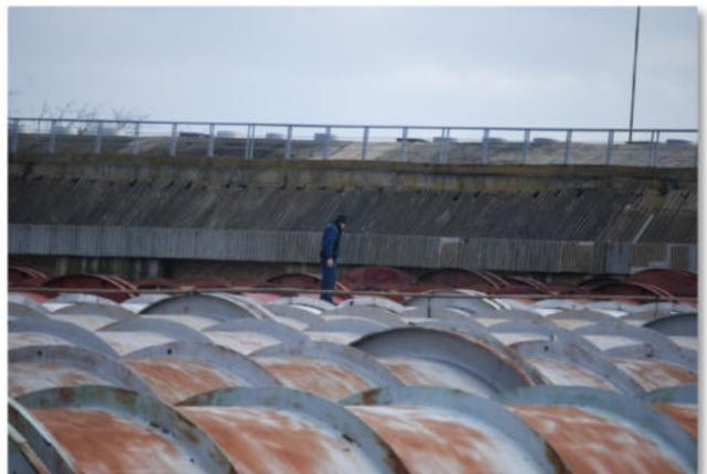
Рис. 1/5 Расходомеры-счетчики IPKA, установленные на Главной насосной станции подачи воды в магистральный канал. Диаметр труб 3600 мм
