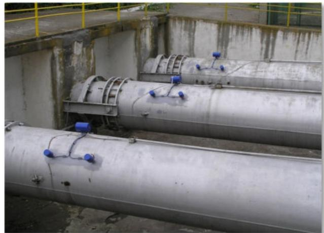
Рис. 1/4 Расходомеры-счетчики IPKA, установленные на «Малых насосных станциях орошения УГМКМ». Диаметры труб от 200 до 800 мм
